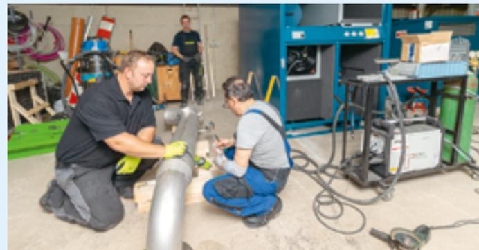
**Kollegen von Metallbau Köpke aus Kremmen bereiten den Anschluss des Hybrid-Gebläses vor. Zwischen 15 und 20% Energieeinsparung werden erwartet.**
