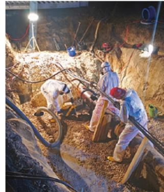
Die Kollegen der Firma Rühlmann Bau GmbH verbinden die beiden Abwasserdruckleitungen.
