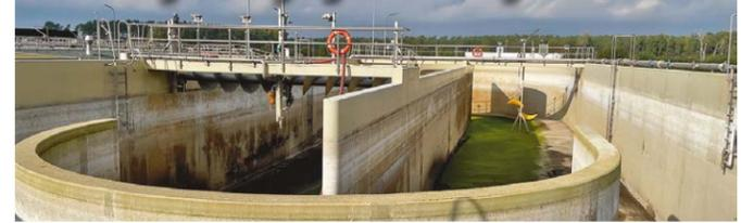
Vor dem Einbau der energiesparenden Plattenbelüfter wurde das Belebungsbecken 3 leergepumpt.
